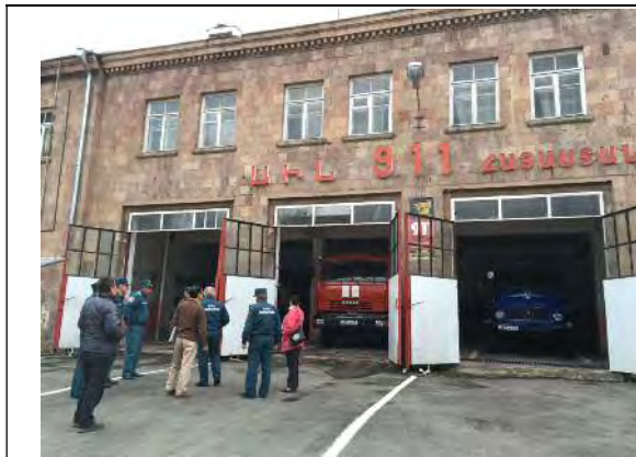
No. 37 Vanadzor (東) 消防署
