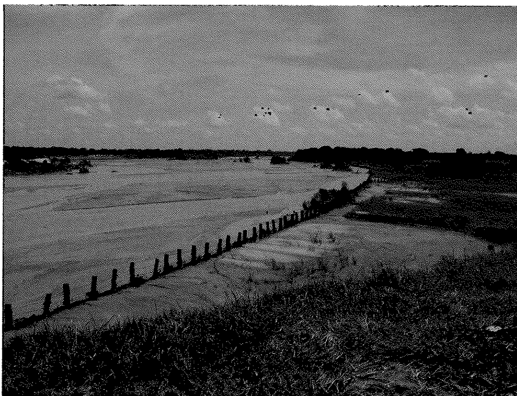
写真(10) 応急対策水制工の状況 (2009年11月)
