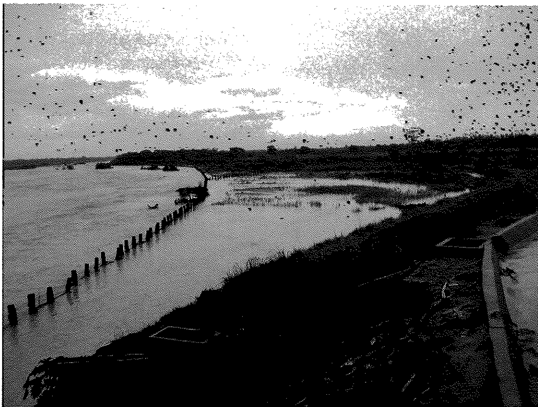
写真(9) 応急対策水制工の出水時状況 (2009年10月)
