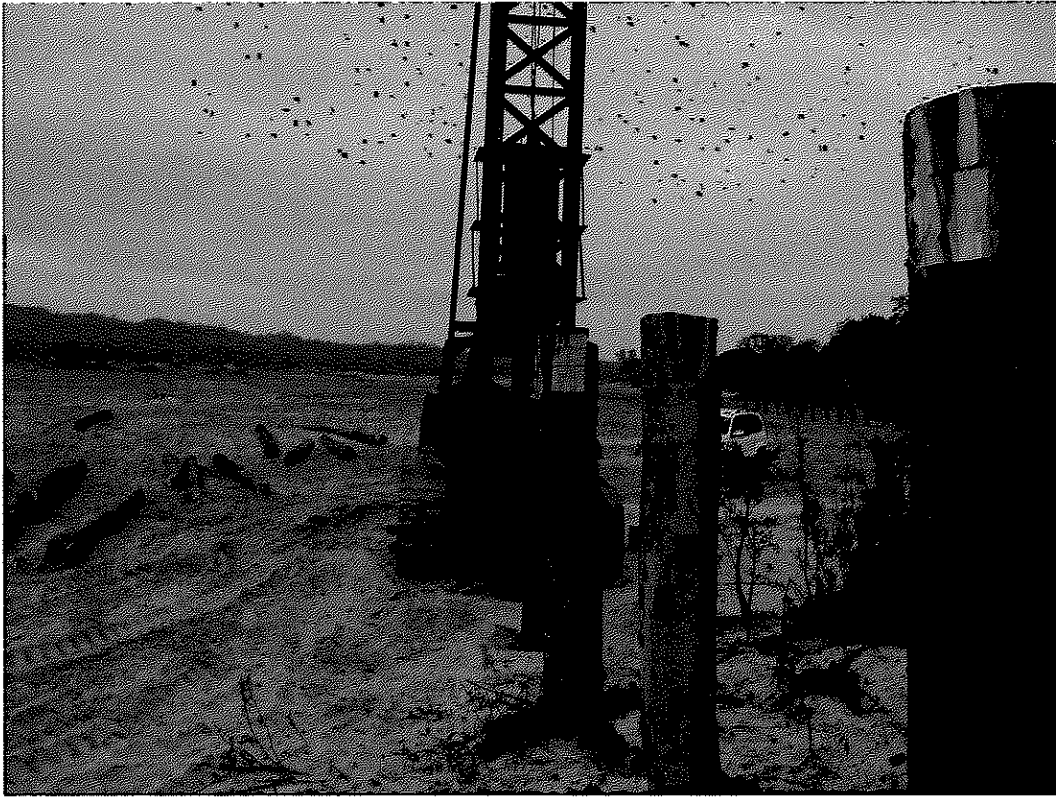
写真(3) SEARPIによる木杭打ち施工事例
