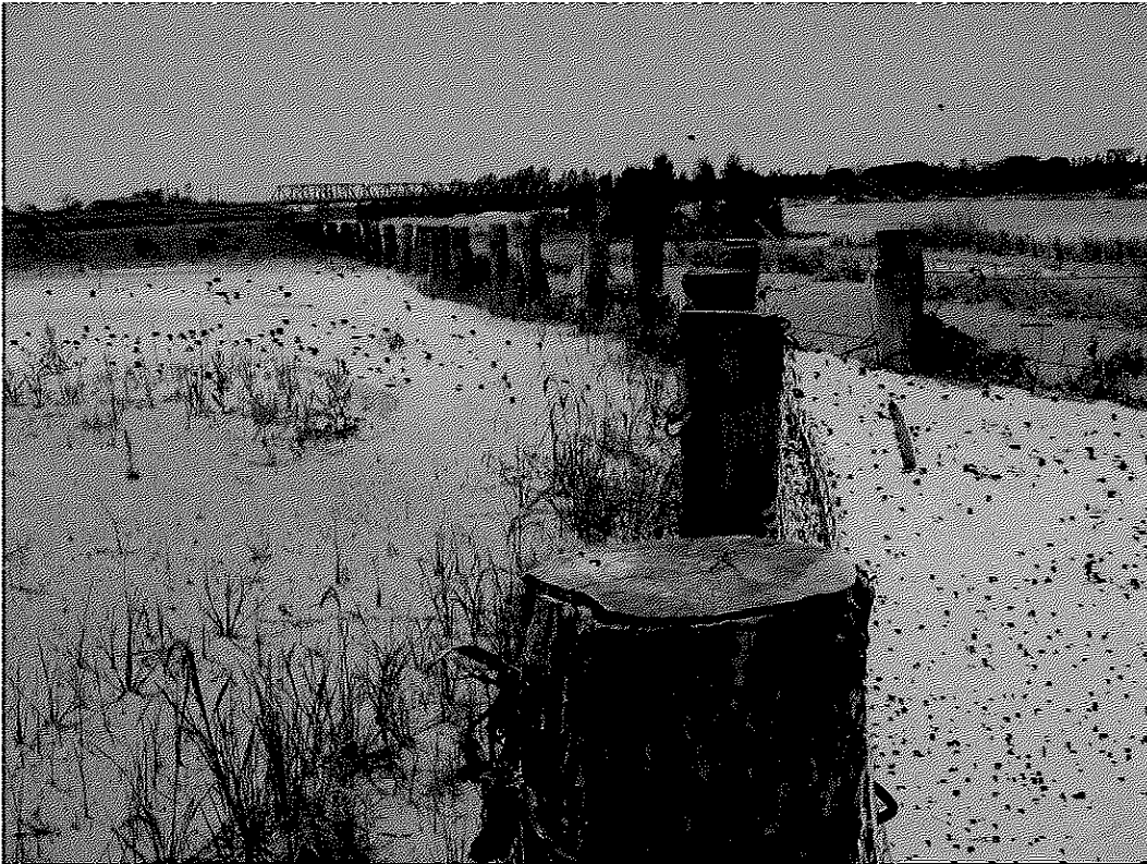
写真(8) 応急対策水制工の状況 (2009年10月)
