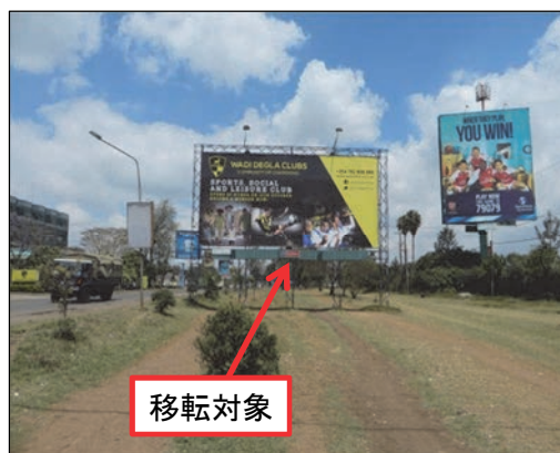
写真 2-2-4 移転対象の広告塔事例
