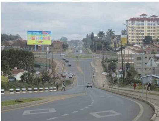
ナイロビ西部環状道路 ウゴンゴ道路にキリマニJCTで接続するナイロビ西部環状道路である。日本の援助で整備を実施した。ナイロビ市の交通渋滞緩和に役立っている。
