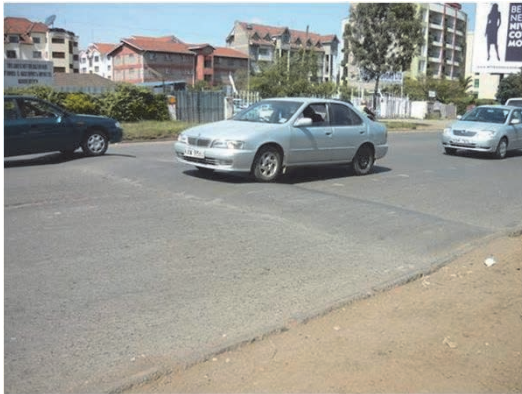
本道上のハンプ 幹線道路上にハンプを設置すると、車両が低速スピードで通過する必要があるため、後続車両がブレーキをかけ、渋滞発生要因となっている。
