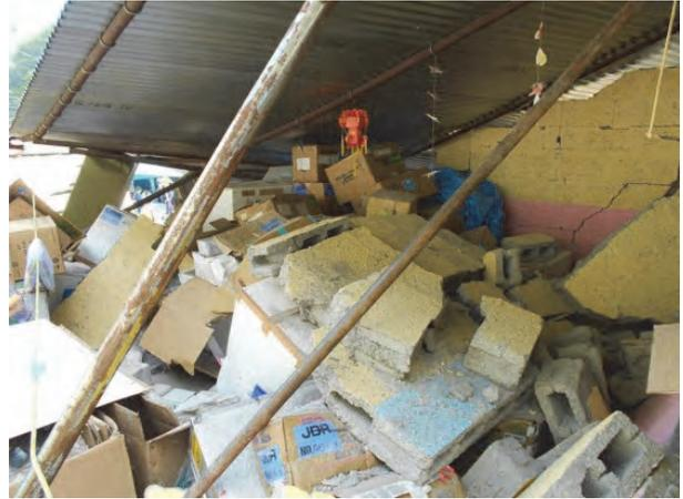
写真3-8 余震で崩壊した倉庫と補強鉄パイプ
