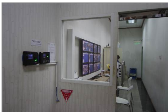
Cyber Building (ジャカルタ) 監視室
