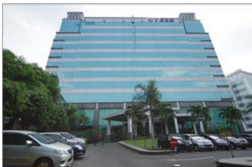
Cyber Building (ジャカルタ) 外観
