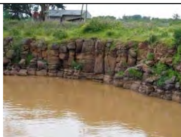
写真-2 アバイ川東岸地域、Charchara Weir の基礎部分に露出する玄武岩溶岩(Qv2-B)
