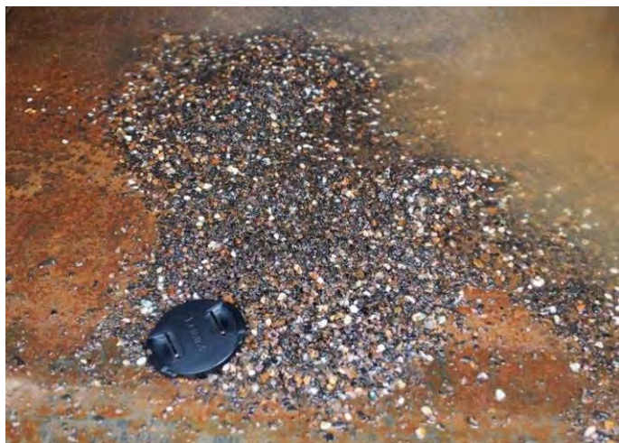
写真-1 揚水試験時に V ノッチ内に上がったグラベル等
