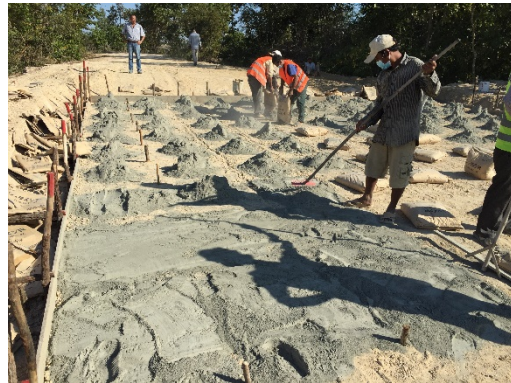
写真 4：#3 現地調査 テスト施工
