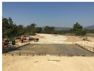
洪水吐兼生活道路完成
