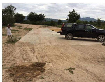
施工現場での土採取 2
