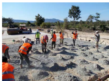
コンポンチュナン洪水吐施工
