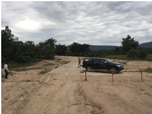
写真 5：#3 現地調査 施工前
