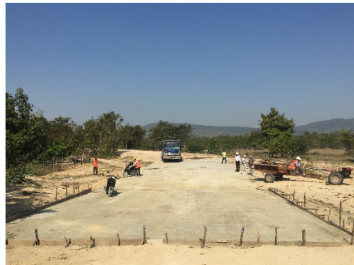
写真 6：#3 現地調査 施工後
