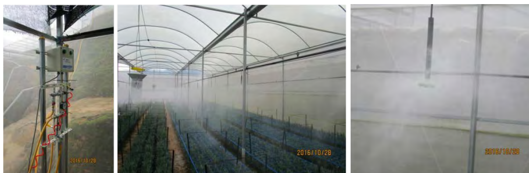
左) 設置した制御ユニット、中) 噴霧開始の状態、右) 四方に広がる細霧
