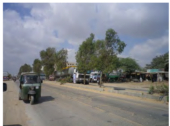
写真-6: 調査対象区間の舗装の損傷。道路側溝の未整備による滞水や重車両による影響と考えられる。
