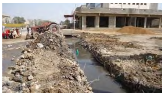
写真 No. 0+890 道路横断カルバート。右はカルバートに流れ込む生活排水 (撮影: 乾季)
