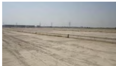
写真 建設中のタンクローリ駐車場
