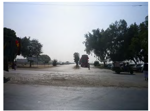
写真-4: ポートカシム交差点。撮影方向のカシム港道路がカシム港に繋がっている。
