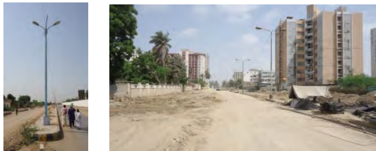
写真（左）N5 のアクセス道路 （右）市内新設道路（建設中）
