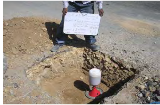
写真2 現場密度試験の状況
