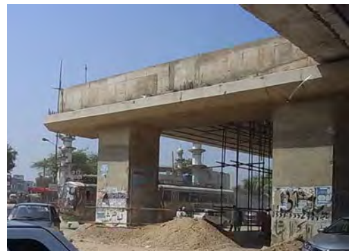
写真 施工中の東側フライオーバー
