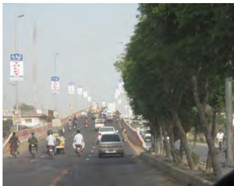
写真 西側フライオーバー（運用中）
