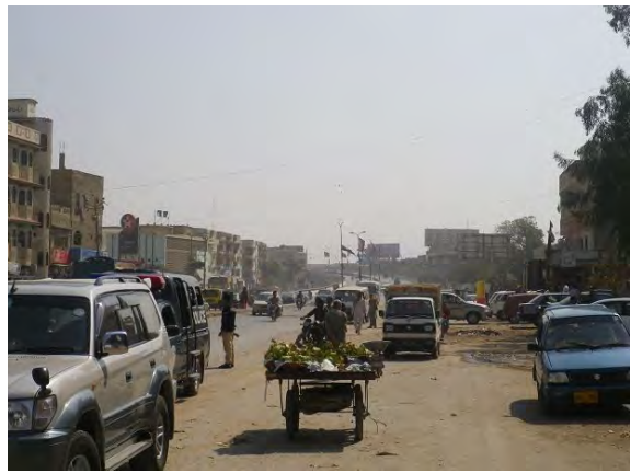
写真-2: 調査対象道路起点のカイダバード。沿道に建物が立地し、路上駐車が多い。
