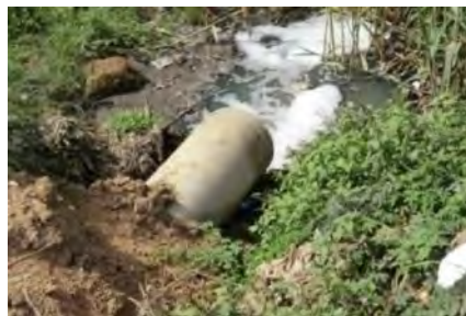
写真 左が No. 11+360 のカルバート。右はカルバート上流部で生活雑排水が流れ込んでいる状況（撮影：乾季）
