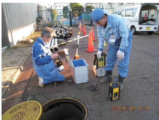
相關式漏水探知機を用いた訓練の様子
