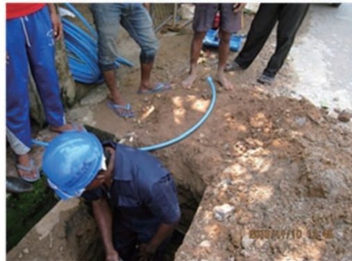
無収水削減対策のために塩ビ管をポリエチレン管に布設替え（Dehiwala 地区）
