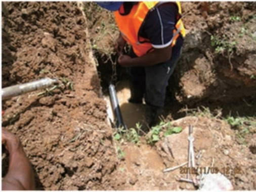
配水管からの給水管取出工事 (南部州 RSC)
