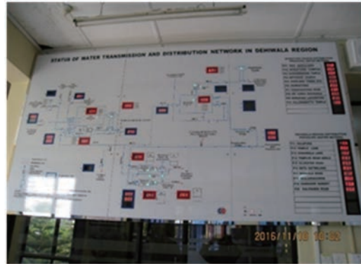
オンラインで表示される送水管・配水管 水圧モニタリングボード： 配水管水圧：-0.6m~12.9m を示す (Moratuwa/Dehiwala 地区)
