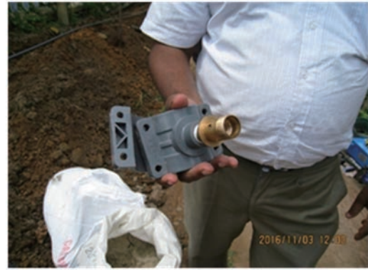
塩ビ製サドル分水栓を使用し不断水で工事 (南部州 RSC)
