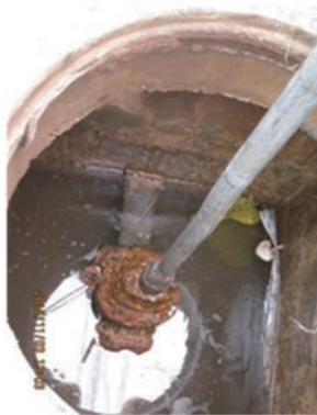
バルブを閉めて断水 (南部州 RSC)
