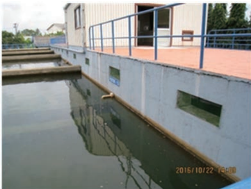
Ambatale 浄水場ろ過池 (濁度は一定程度除去)
