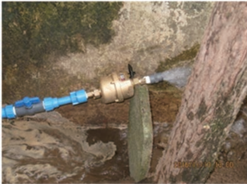
配管後の排水作業 (Dehiwala 地区)
