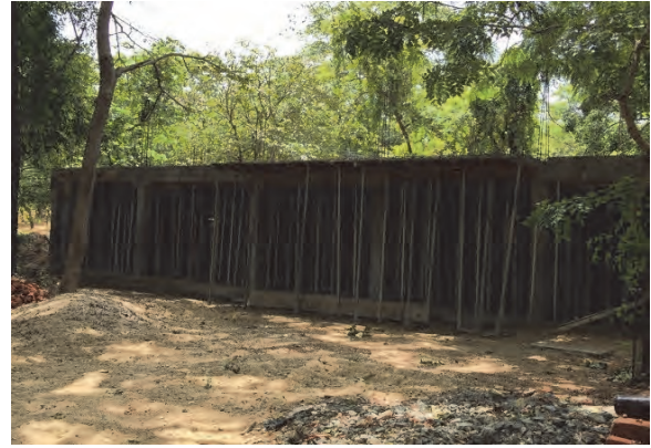
博物館近くの建設中トイレ施設
