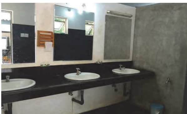
既存トイレ内観1
