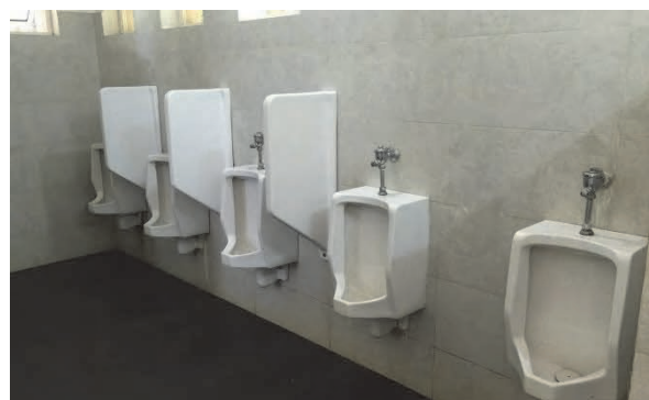
既存トイレ内観2
