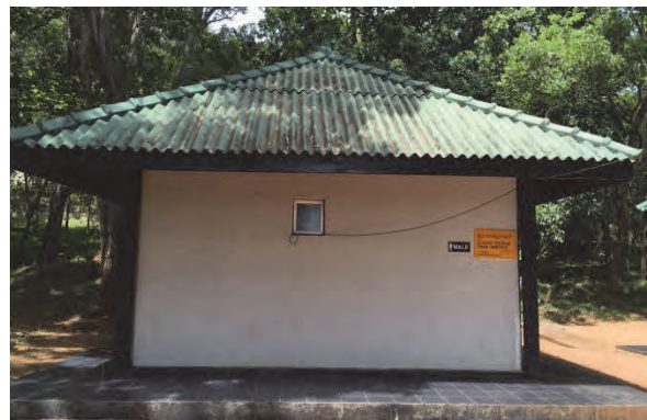
既存のトイレ外観
