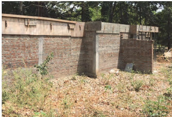
建設中トイレ施設の裏側
