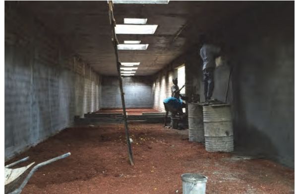
建設中の外国人向けトイレ内観
