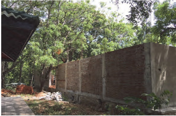
建設中の外国人向けトイレ
