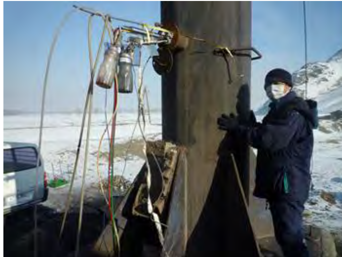
Зураг 10-5 Яндангийн хэсэгт багаж төхөөрөмжүүдийг бүрэн угсарсан байдал (Автомат багаж)
