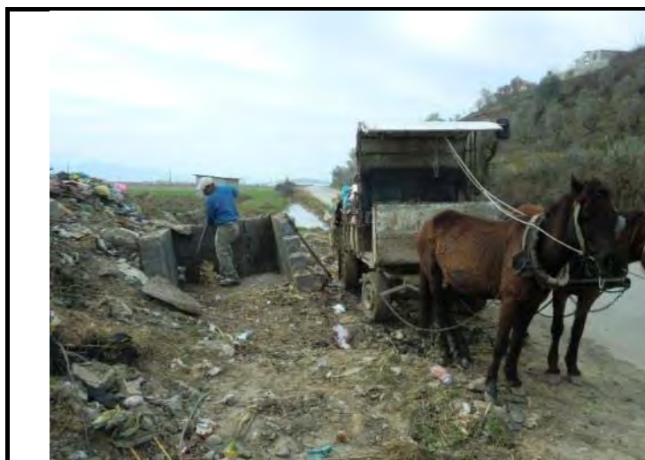
ツェリックの農村地帯におけるコンクリート製排出地点と馬車による収集システム (2016 年 1 月)
