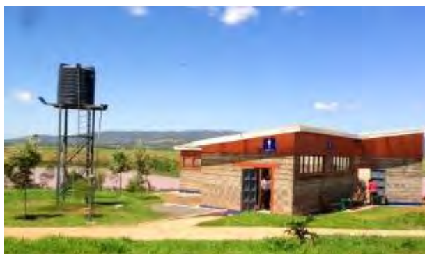
写真6 Machakos カウンティが設置した 公衆トイレ（パイロット候補）
