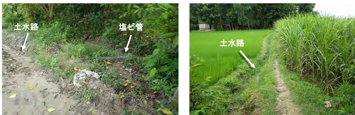
図 5-4-1 3 次水路から分岐させた塩ビ管と圃場内水路（左）、水田脇に延びる圃場内土水路（右）：Bagmati
