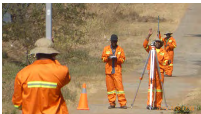
水準測量の作業風景
