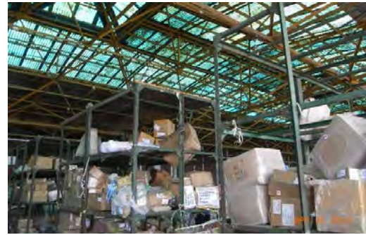
底下の保管状況
