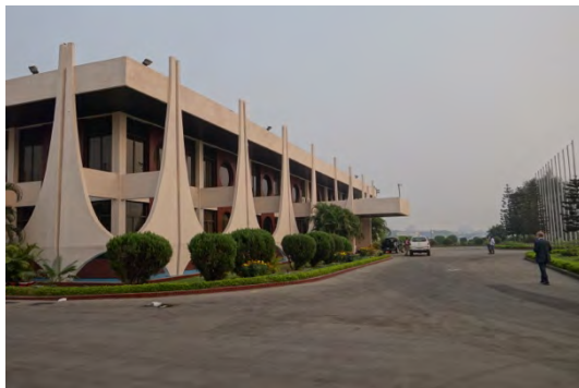
エプロン側エントランス
