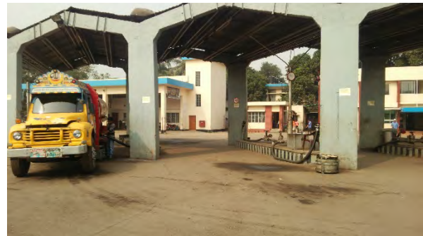
既存タンクローリー受入設備
