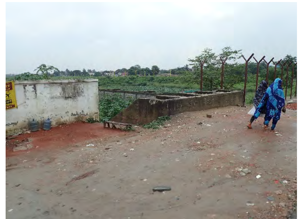
北西コーナー部の排水路
