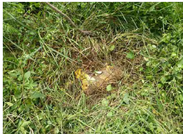
仮基準点（損傷している）
