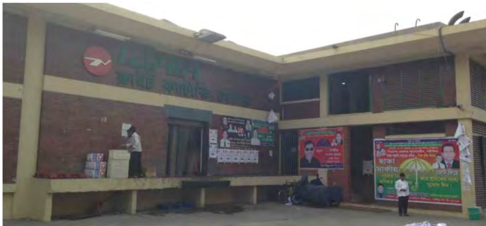
3-44 ケータリング施設の現況写真
