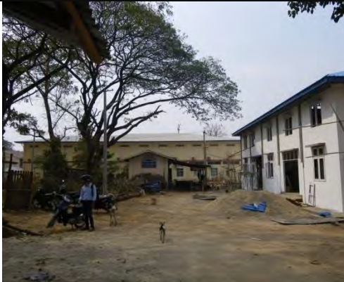
写真-1： 建設予定地 右手に見える建物は新薬品倉庫。写真奥の2階建て建物は、新手術・画像診断棟。
