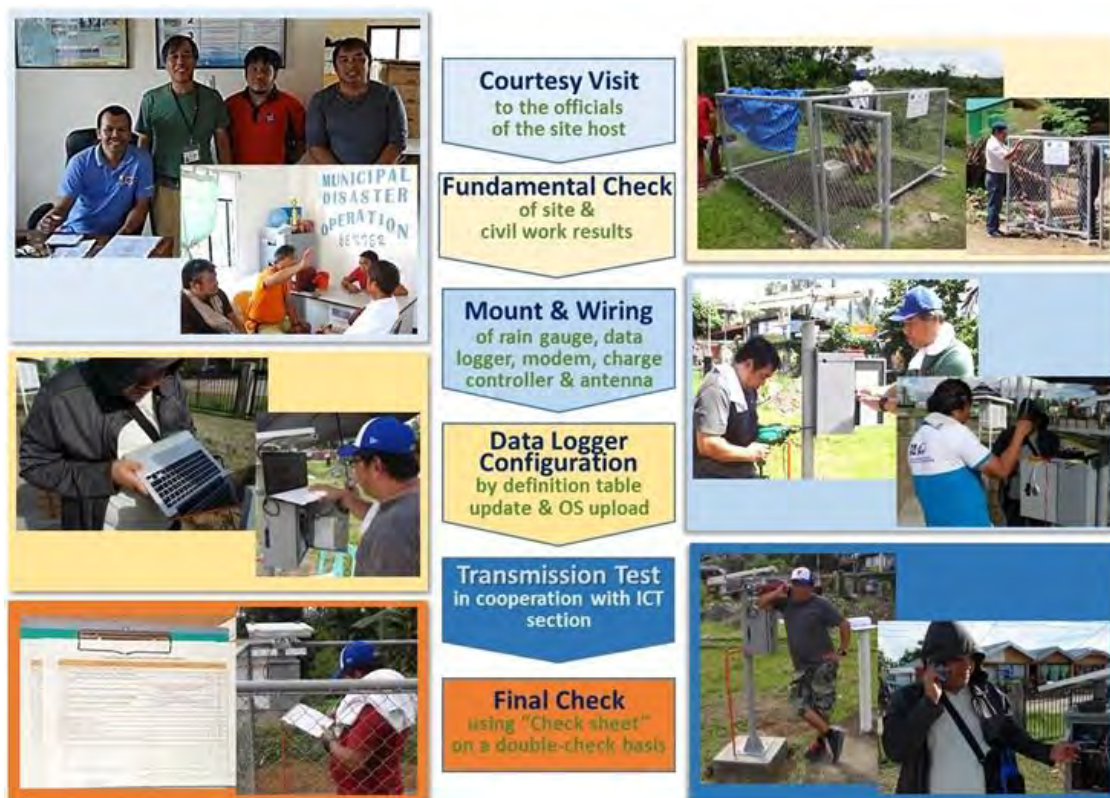
図 3-3-12 現地設置作業の過程
