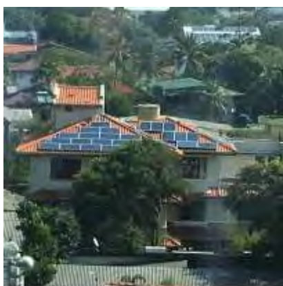
図5 屋根置き太陽光発電設備の設置状況
