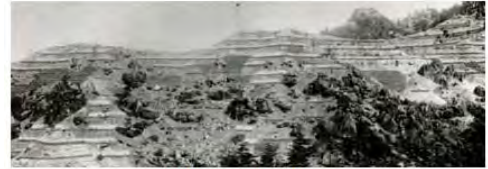
山腹工施工状況
