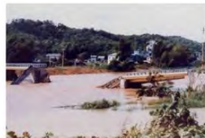
写真 2.2-4 大津市石居の橋梁流出 (出典) 近畿地方整備局
