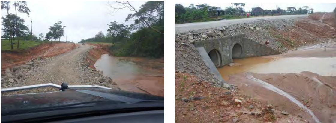
図 3-18 大西洋岸道路接続プロジェクト工事の様子
