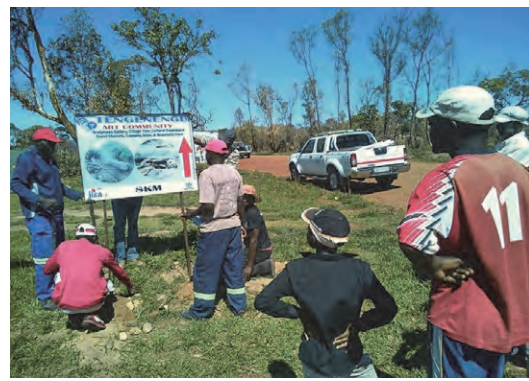
テンゲネゲの道路標識の設置
