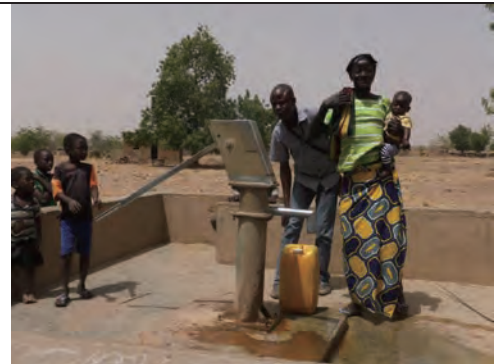
中央プラトー州クルヴェオゴ県 スルグビラ コミューン Zoundri (ズンドリ) 村 我が国の無償資金協力で 1999 年建設。稼働し ているが水量が少ない。上部構造を中古ポンプ から挿げ替えた。
