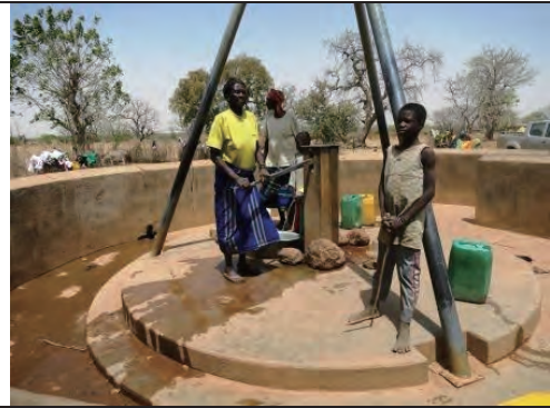
南部中央州 Kayao コミューン Kossilci 村 サウジラピア基金で 1988 年建設、ドイツ製 Kardia ポンプは建設当時のもの。稼働している が要更新。コンクリートの付帯施設は使える。
