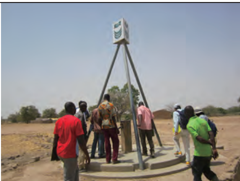
南部中央州 Kayao コミューン Kinkirou 村 修復予定の井戸
