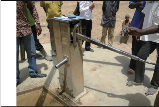
南部中央州 Kayao コミューン Kinkirou 村 サウジラピア基金で 1986 年建設、ドイツ製 Kardia ポンプは建設時のもの。稼働している が、老朽化著しく要更新、塀は崩れている。
