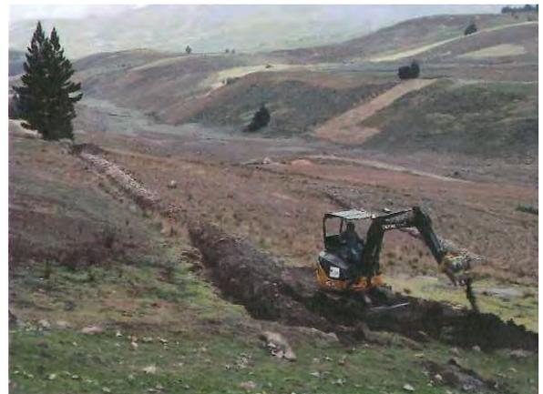
水土保持のための浸透溝設置工事
