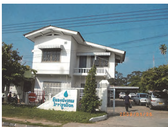
写真 5：サバナケット県農林局灌漑課。本館の向かいに位置し、写真の建物 2 階すべてが本案件の執務室として提供される。
