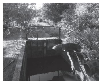
幹線水路への直接供給
