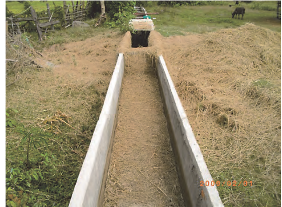
写真 14: 新たに農家グループが基金を集めて延伸した幹線水路(40m)。同地区は洪水多発のため、乾季灌漑が主体(ゲンコックヌア地区)
