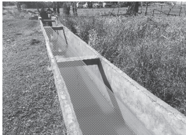
通水量が水路規格の半分の水路（圃場に水がのらない）
