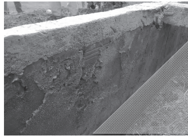
通水量が水路規格の半分の水路（圃場に水がのらない）
