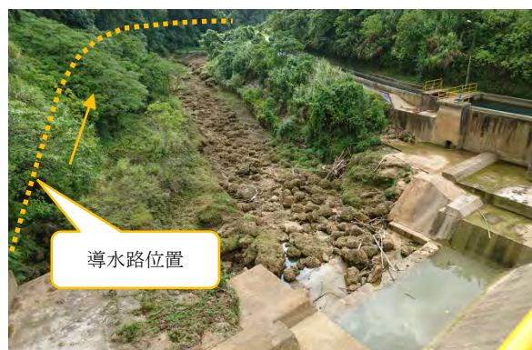
写真 7-2-6 導水路候補地点
