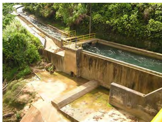
写真 5-5 沈砂地と導水路
