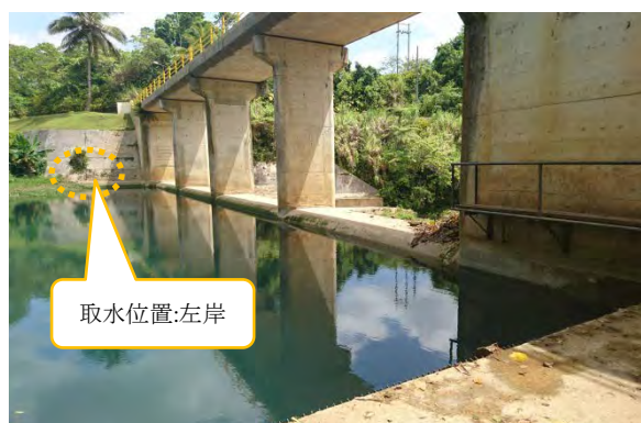
写真 7-2-5 既設取水ダム地点
