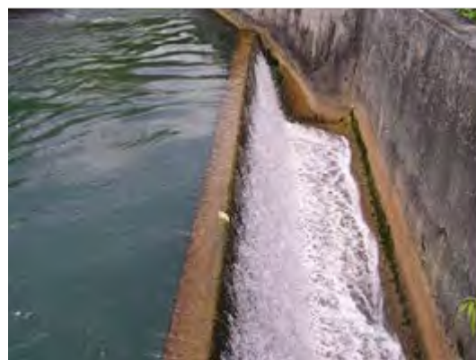
写真 5-13 水槽余水吐越流状況
