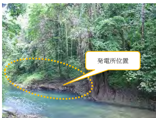
写真 7-2-7 発電所候補地点
