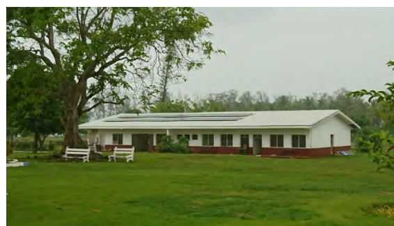
写真 5-30 ルーガンビル・カレッジ(10 kW)
