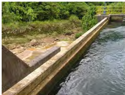
写真 5-6 沈砂地越流部堤頂のかさ上げ状況
