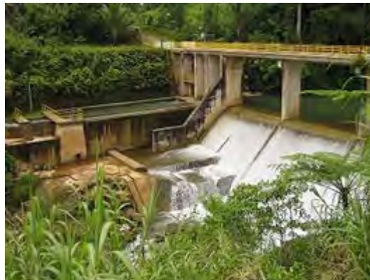
写真 5-2 取水堰下流側と沈砂地
