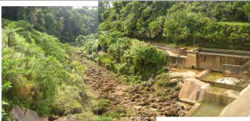
写真 5-7 堰下流の河川状況（取水堰からの越流量=0、河川自流=発電水量時）
