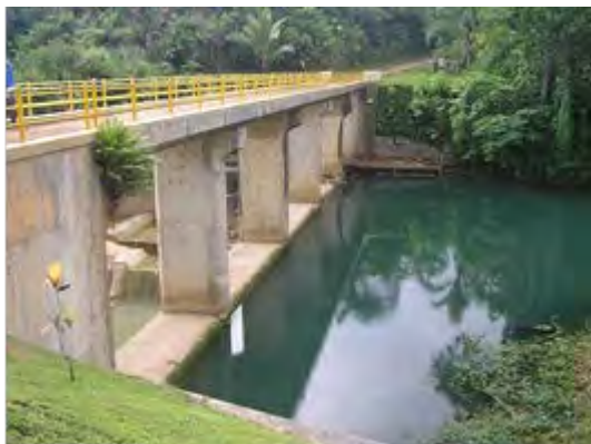
写真 5-1 取水堰上流側
