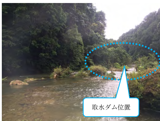
写真 7-2-11 取水ダム候補地点
