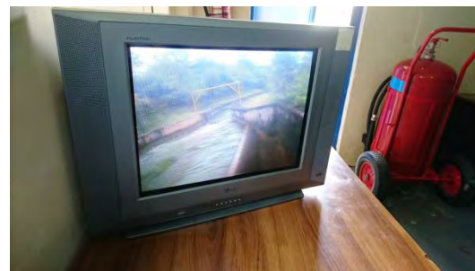
写真 5-19 余水吐モニター
