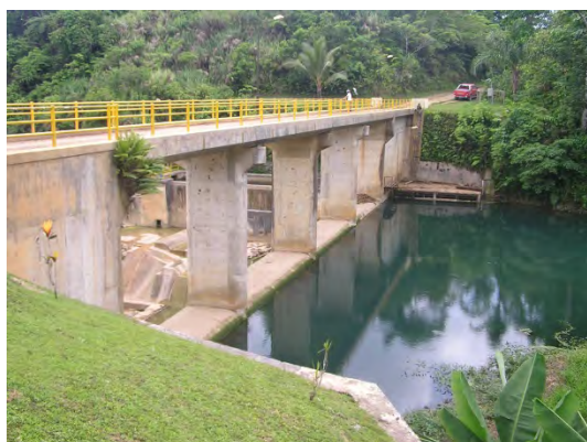
写真 7-2-1 既設取水ダム地点
