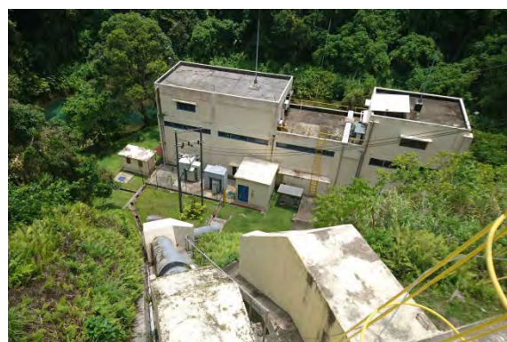
写真 7-2-4 既設発電所地点
