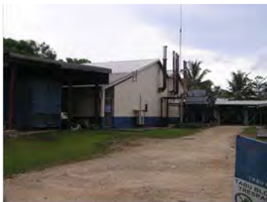
写真 5-22 ディーゼル発電所建屋
