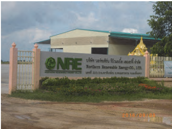
NRE バイオマス工場 (Chachoengsao 県)
