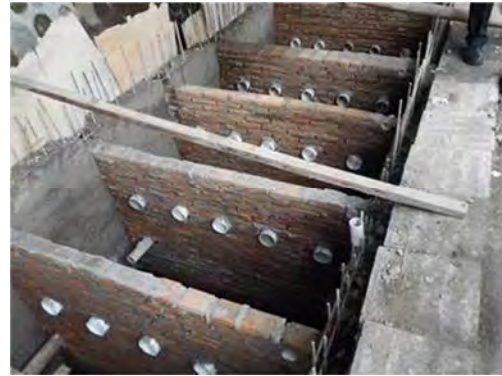
図 13 施工中の自家製タイプの大型 Septic tank の例（200 人程度の処理能力）
