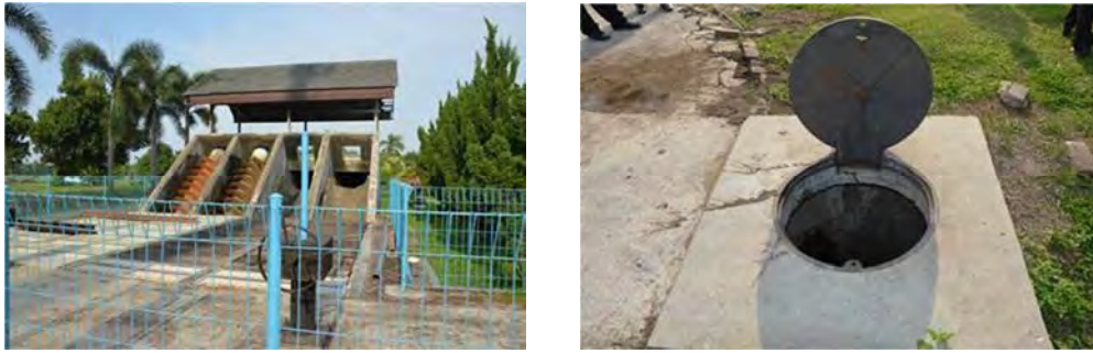
図 7 Cemara 下水処理場の最初沈殿池（左）と Septic tank 汚泥の投入口（右） （出典：調査団撮影）
