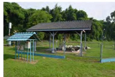
図 6 Cemara 下水処理場の施設概要（左：UASB 反応槽、中央：好気性処理池、右：ガスホルダー 2 ）
