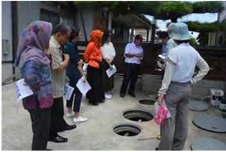
本邦受入時の浄化槽設置現場見学（2016年8月）
