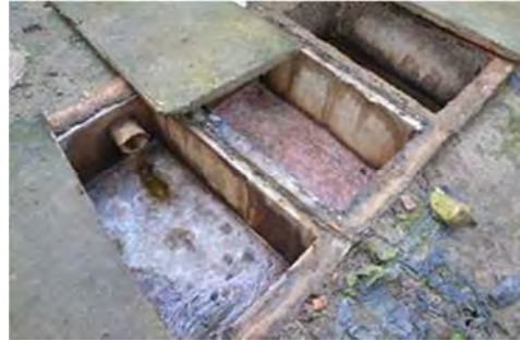
Septic tank 調査（2016年8月）
