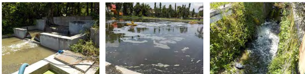
図 2 スラカルタ市の下水処理場（Mojosongo 下水処理場） （左：流入槽、中：ラグーン、右：放流口）（出典：調査団撮影）
