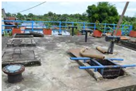
マカッサル市汚泥処理施設視察（2017年3月）
