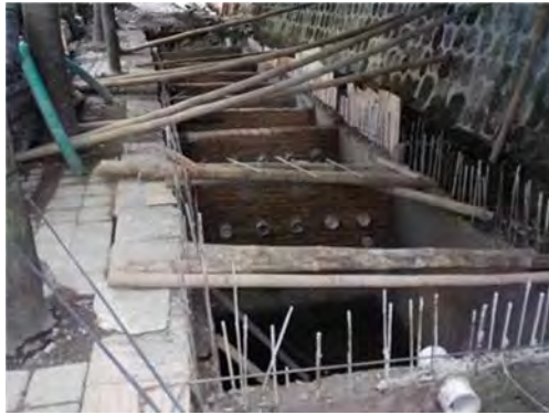
図 13 施工中の自家製タイプの大型 Septic tank の例（200 人程度の処理能力）
