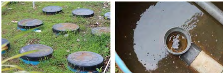
図 22 施設 2（バンドン工科大学キャンパス）の外観及び槽内の状況 (出典：調査団撮影)
