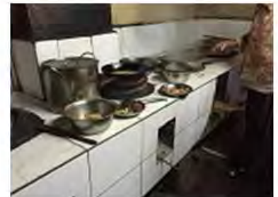
⑨ 高床式カマド(開口部より、薪を挿入)/街中のホテル
