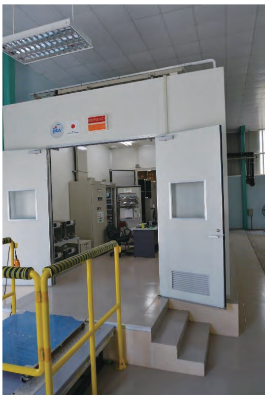
冷蔵庫試験設備外観
