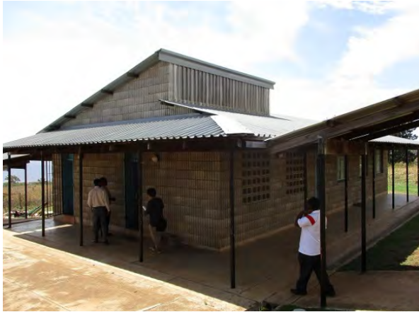
写真 13. 類似校 Salem 中等学校 農業実習室 講義室と飼育場、倉庫で構成されている。飼育場は通風と採光に配慮されている。
