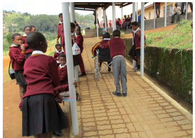
写真 6. 類似校 Entuthukweni 小学校 車椅子使用生徒の移動を補助する生徒。スロープの勾配が急であり、床仕上げも凸凹が見られる。
