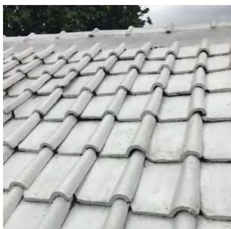
塗布後 屋根表面
