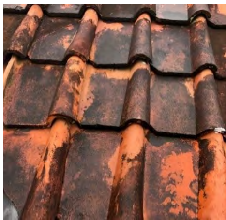
塗布前 屋根表面
