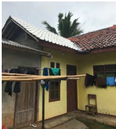
テスト現場 外観 塗布後
