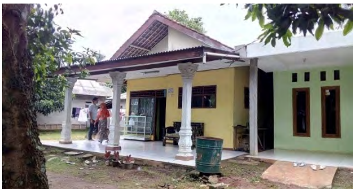
テスト現場 外観
