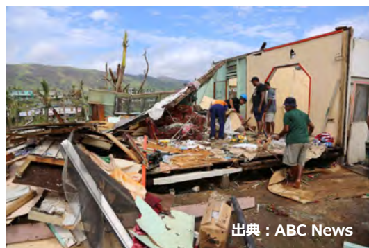
図3 ウィンストンによる被害状況 (フィジー)
