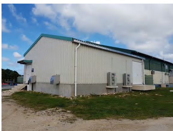
蓄電設備棟（ポア発電所） 太陽光発電施設のための蓄電設備が格納されている。
