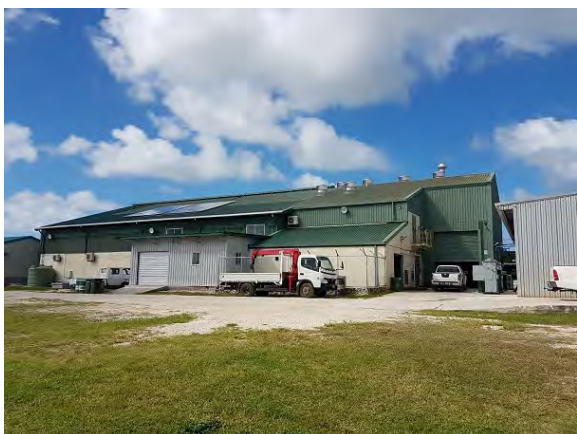
ボア発電所 (No. 2 建屋 : ディーゼル発電) MAK 製発電機 2 台が格納されている。
