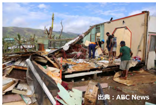
図 2-33 ウィンストンによる被害状況(フィジー)
