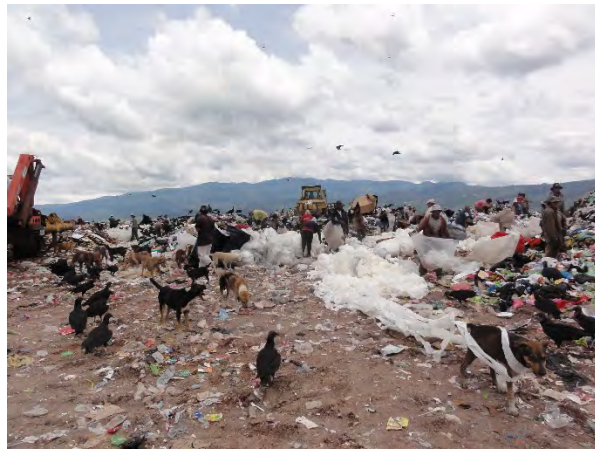
Relleno sanitario actual (1)
