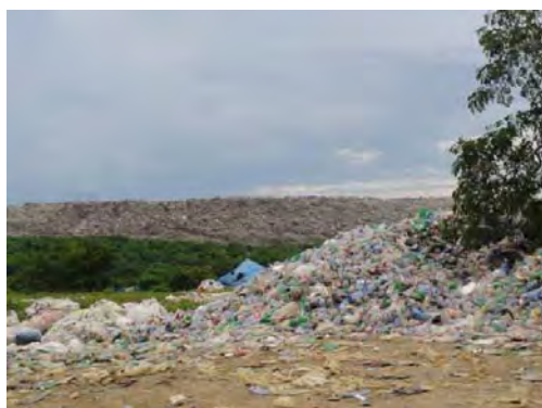
Relleno sanitario actual de la Duquesa
