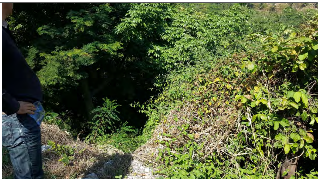
Acceso para zona de construcción de primer estación de bombeo
