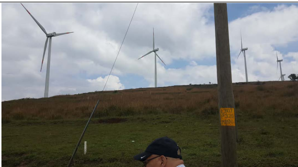
Zona de construcción estación de distribución Cerro de Hula
