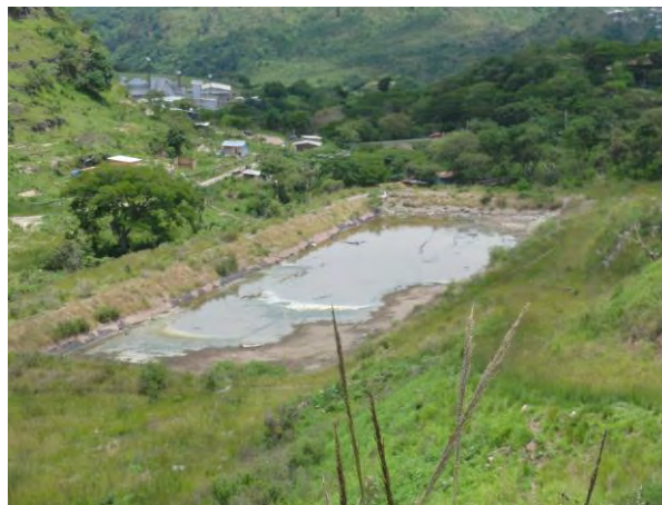
Laguna de regularización de lixiviados
