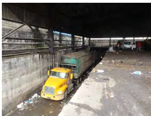
Estación de transferencia actual
