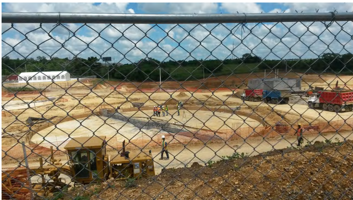
Estado actual de los trabajos constructivos.
