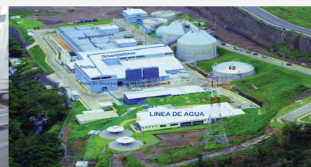
PTAR Los Tajos
