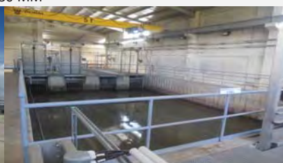
Cámara de Carga
