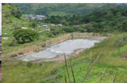
Laguna de regularización de lixiviados
