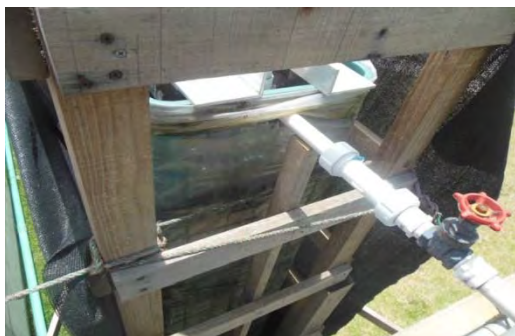
Flujo descendente con Esponja Colgante (DHS) Planta piloto en la PTAR Los Tajos
