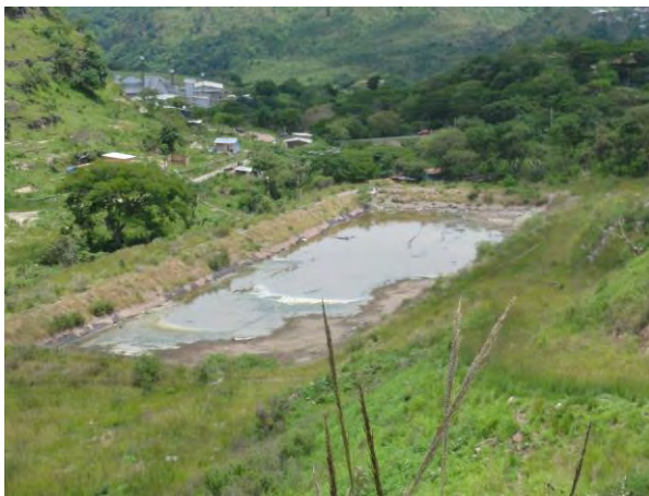
Laguna de regularización de lixiviados
