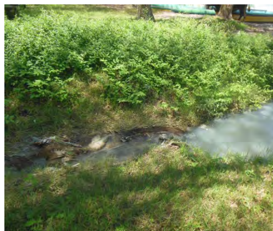
Entrada de aguas residuales al algo provenientes de la colonia
