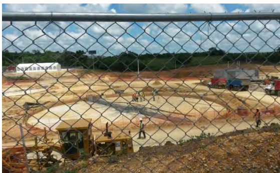
Planta de tratamiento en construcción La Zurza
