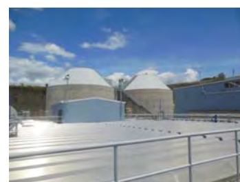
Planta de primer tratamiento existente (con cubierta)
