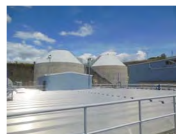
Planta de primer tratamiento existente (con cubierta)
