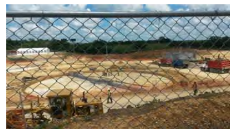
サントドミンゴ市La Zurza下水処理場建設中 (散水ろ床系)
