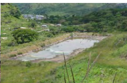
Laguna de regularización de lixiviados
