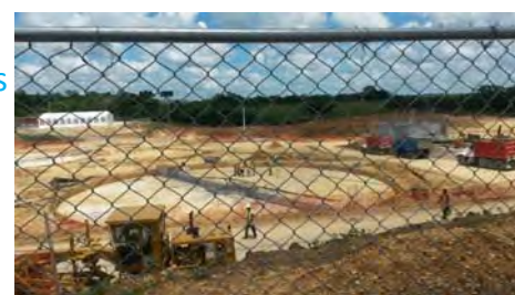
Obra de planta de depuración de La Zueza en la ciudad de Santo Domingo (sistema de filtro percolador)
