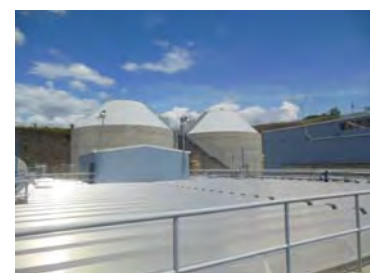
Planta de primer tratamiento existente (con cubierta)
