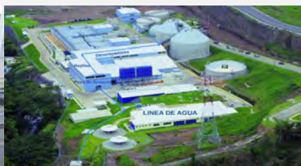
PTAR Los Tajos
