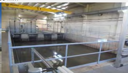
Cámara de Carga
