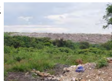
サントドミンゴ都市圏のドゥケサ広域処分場
