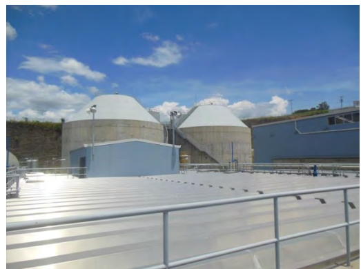
既存沈殿池（覆蓋付き）と汚泥消化槽
