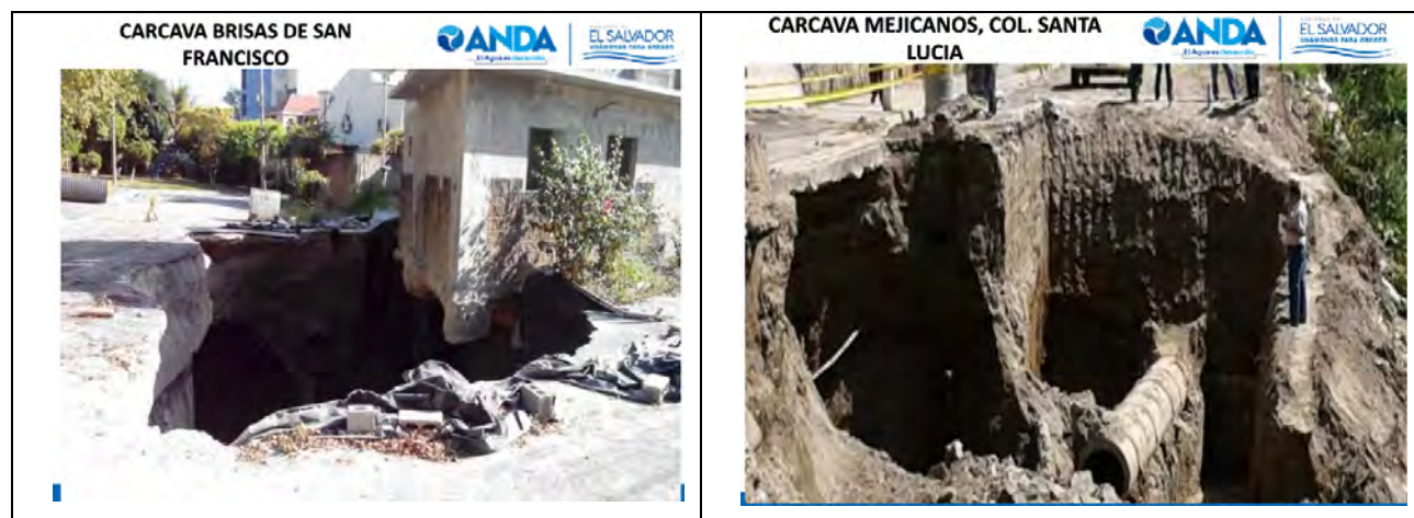
図 2-12 サンサルバドル市内で発生した老朽管に起因した道路陥没
