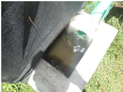
DHS試験設備からの処理水ピット
