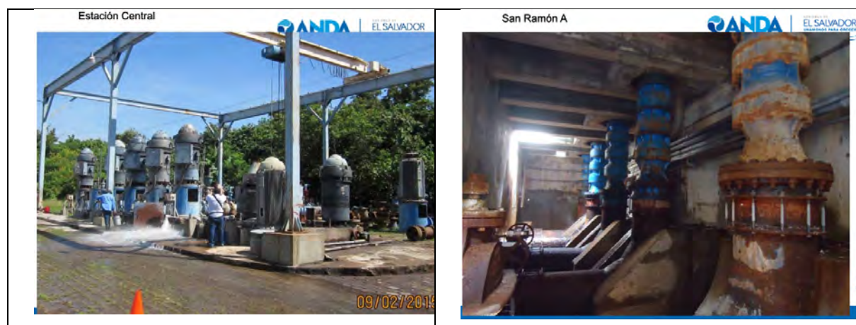
図 2-13 サンサルバドル市内ポンプ場での大量漏水と老朽ポンプ（北部ゾーン）
