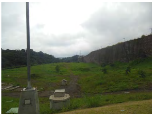
二次処理施設建設用地（Tajo Norte）
