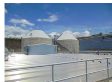
既存一次処理施設(覆蓋)
