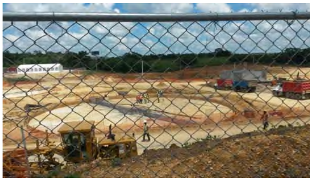
建設中のLa Zurza処理場
