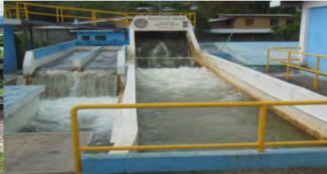
Entrada de agua del Orosi-I en la Planta Potabilizadora de Aguas Tres Ríos
