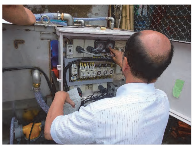
制御盤内の設定作業
