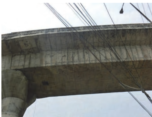
写真 3.5.3 ウェブにおける水平及び斜め方向ひび割れ
