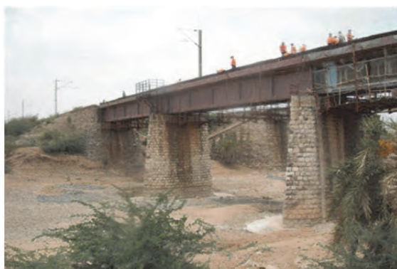
写真 3.7.65 No. 129 鉄道橋全体図
