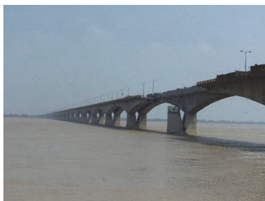
写真 3.6.2 マハトマガンジー橋上部工一部撤去状況
