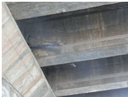
写真 3.7.30 切断された外ケーブル
