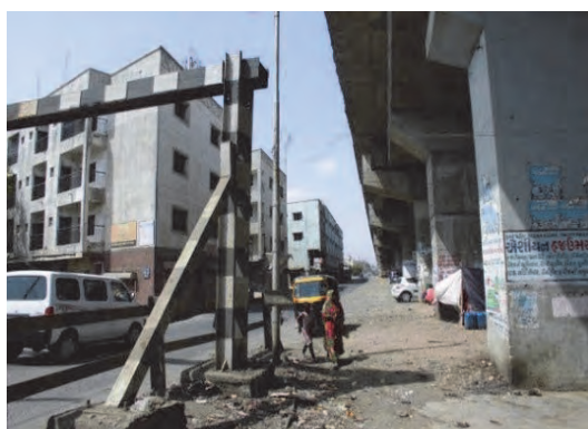
写真 3.7.35 跨線橋から北東方面状況
