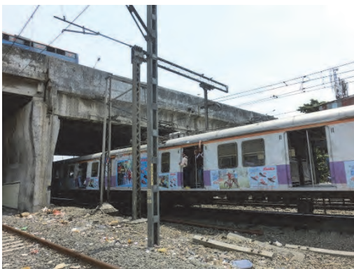
写真 3.7.21 マヒム跨線橋全体図
