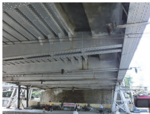
写真 3.7.18 主桁及び横桁
