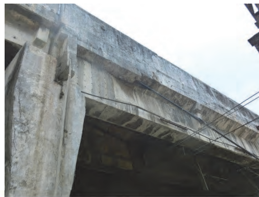
写真 3.7.23 外ケーブル設置状況
