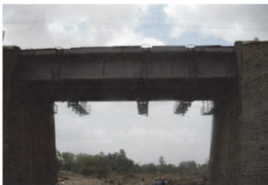
写真 3.7.70 No. R5 鉄道橋全体図
