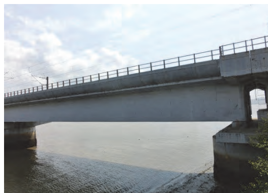
写真 3.7.43 No. 73 鉄道橋全体図
