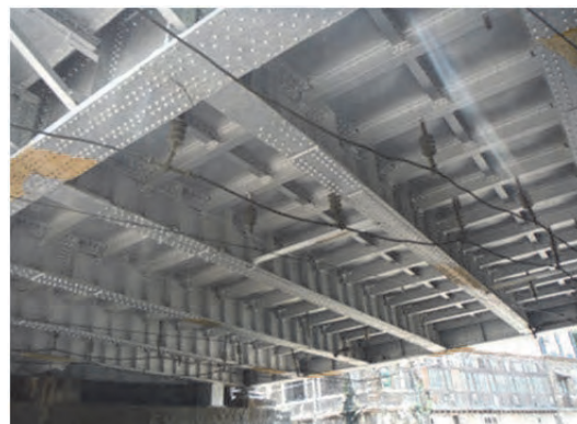
写真 3.7.1 フェレーレ跨線橋（左：全体図、右：主桁及び横桁状況）
