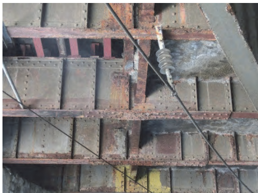
写真 3.7.13 錆及び下フランジの断面欠損
