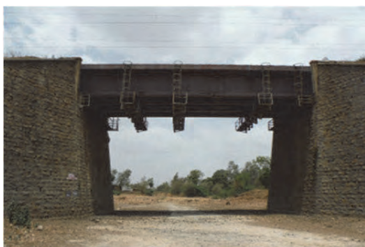
写真 3.7.74 No. R8 鉄道橋全体図
