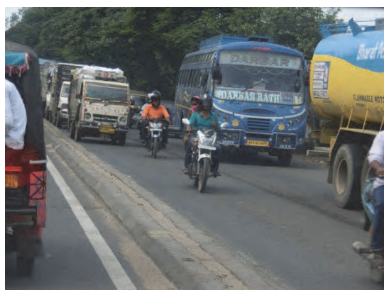
写真 3.6.1 既存マハトマガンジー橋の渋滞状況
