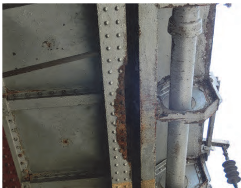
写真 3.7.6 下フランジ断面の欠損状況
