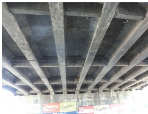
写真 3.7.29 主桁及び橋台
