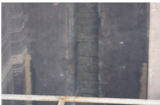
写真 3.7.76 露出鉄筋
