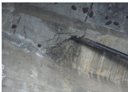
写真 3.7.24 外ケーブル設置状況
