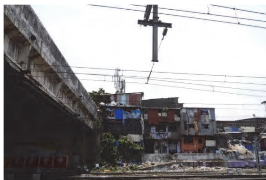
写真 3.7.26 跨線橋から南東方面状況
