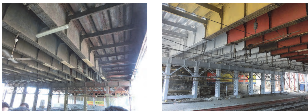
写真 3.7.9 マハラクスミ跨線橋現状 (左側：全体図、右側：再塗装状況)
