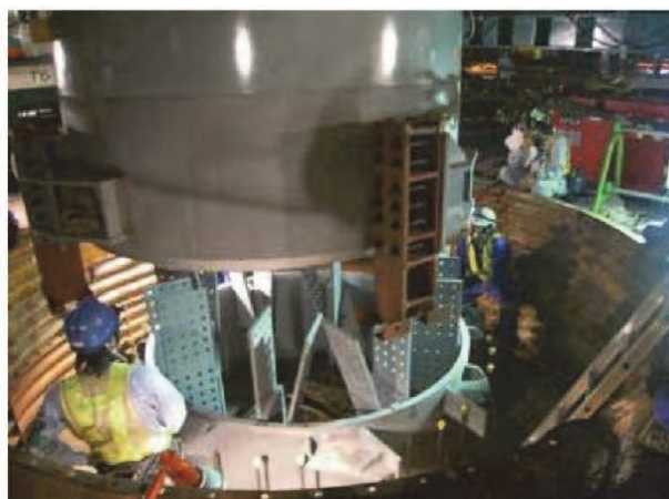
図 6.2.7 鋼管ソケット接合の概念図及び現場写真
