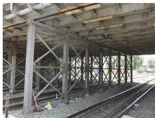
写真 3.7.5 主桁及び橋脚の状況
