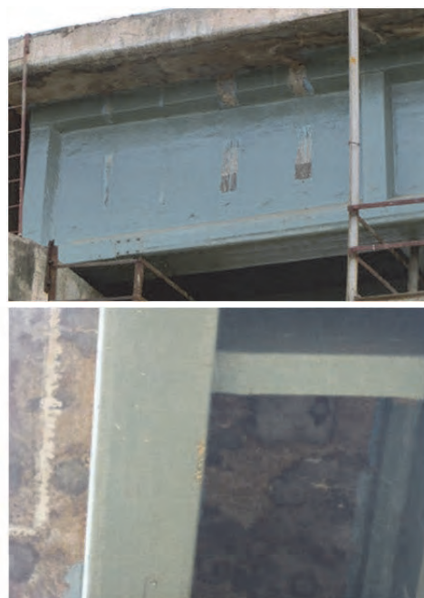
写真 3.7.57 CFRP 及びエポキシ樹脂による補修
