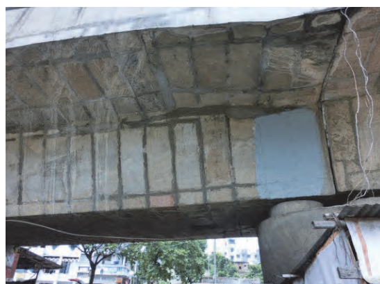
写真 3.5.2 モルタル充填状況
