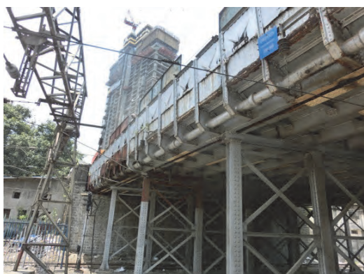
写真 3.7.4 バラシス跨線橋全体図
