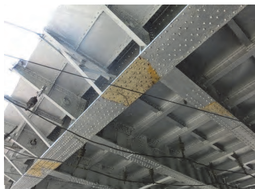
写真 3.7.2 主桁及び横桁状況
