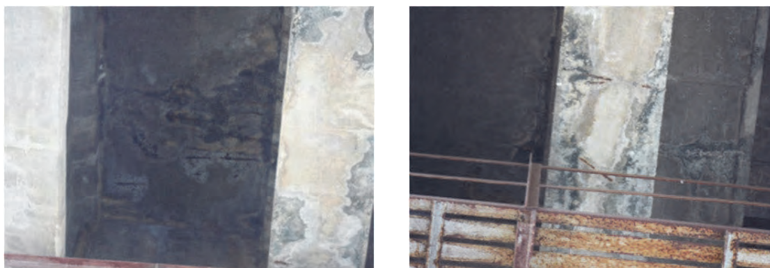
写真 3.7.72 鉄筋露出状況
