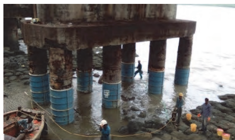
写真 3.7.52 損傷杭基礎の修復
