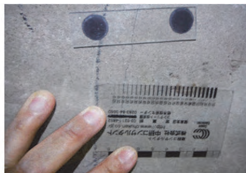
写真 3.7.34 床版に発生したひび割れ
