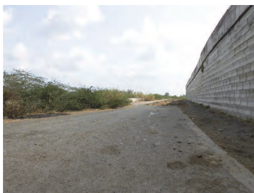
写真 3.7.41 北側跨線橋から南西方面状況
