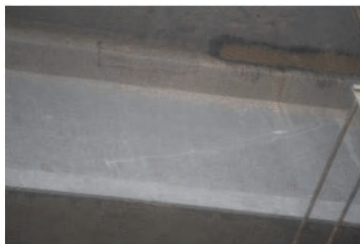
写真 3.7.77 補修ひび割れ跡
