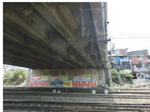
写真 3.7.22 主桁及び橋台
