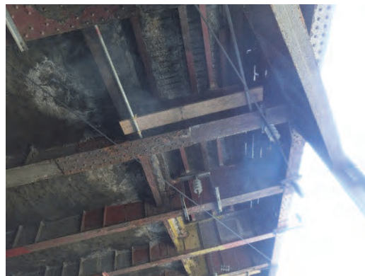
写真 3.7.14 床版下面コンクリートの剥落 及び遊離石灰の発生
