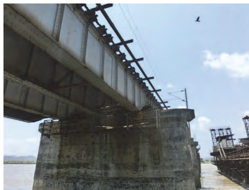
写真 3.7.51 鋼桁及び橋脚
