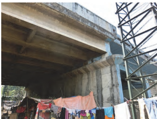
写真 3.7.28 ゴレガオン跨線橋全体図
