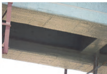
写真 3.7.62 CFRP 及びエポキシ樹脂による補修
