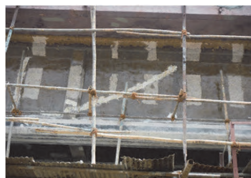
写真 3.7.67 補修作業状況
