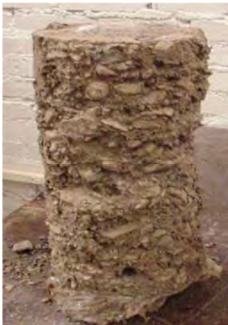
写真 セメント安定処理路盤の乾湿による劣化
