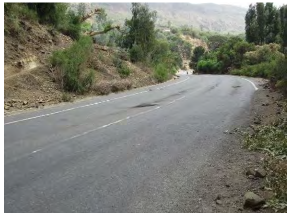
写真-4：地方部幹線道路（山地部）
