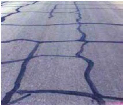
写真 アスファルト表層のブロックひび割れ 出典：NCHR 写真 アスファルト表層のずれひび割れ 出典：JICA 調査
