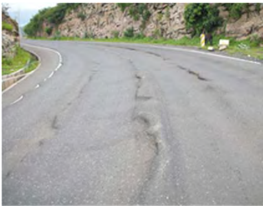
写真-5：地方部幹線道路（山地勾配部）
