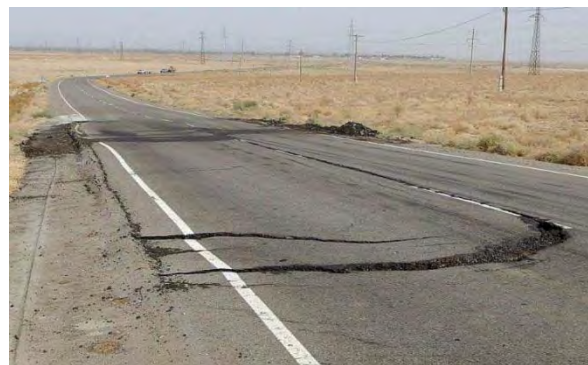
写真 アスファルト表層のブロックひび割れ 出典：NCHR 写真 アスファルト表層のずれひび割れ 出典：JICA 調査
