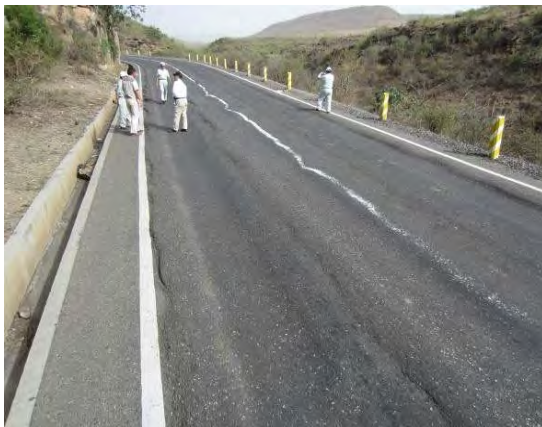
写真-3：地方部幹線道路（山地勾配部）
