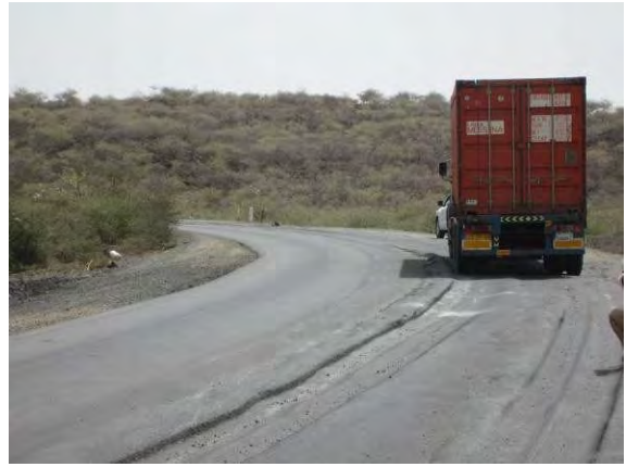
写真-2：地方部幹線道路（丘陵部）
