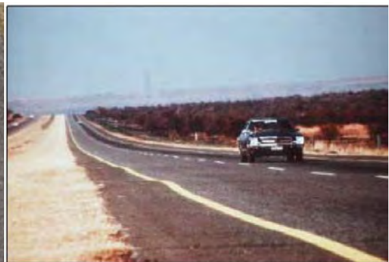
写真 南アフリカの事例（膨張性土により盛り上がったカルバート上の道路） 出典：SAPEM Chapter-6
