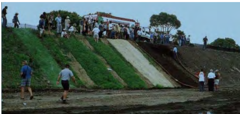
写真：分散性土壌対策の現場試験
