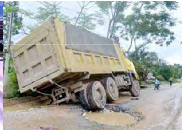
過積載車両によるポットホール
