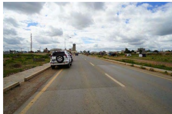
ザンビア：ルサカ市 Tokyo Way の状態 （良好：7ヶ月経過（一雨季経過）した補修区間）
