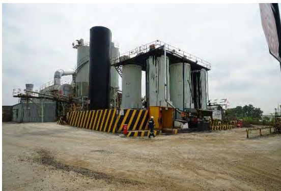
南ア：Much Asphalt の連続式プラント（南ア最大手のアスファルトサプライヤー）
