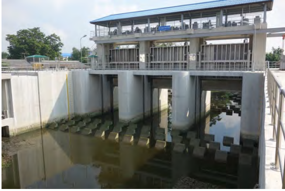
クラマン水路洪水防御水門 (第2次調査) *
