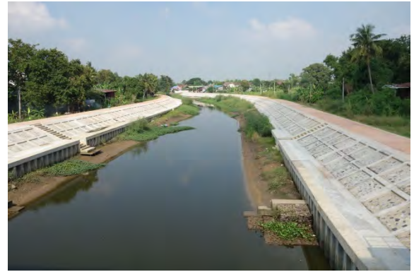
ハントラ水路護岸 (第2次調査) *
