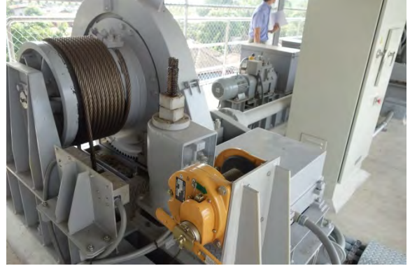
クラマン水路洪水防御水門 (ウィンチ) (第2次調査) *
