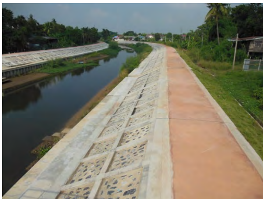
ハントラ水路護岸 (第2次調査) *
