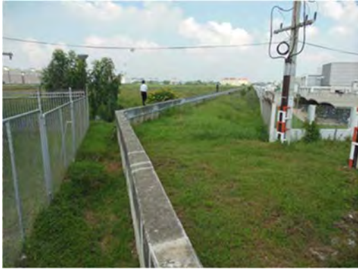
アユタヤ周辺の工業団地が自主的に建設した 洪水防御壁 (第2次調査団)
