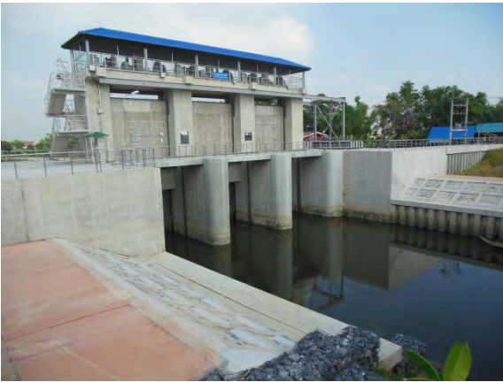
ハントラ水路洪水防御水門 (第2次調査) *
