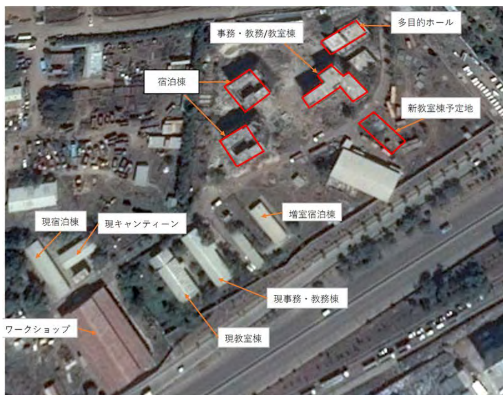
図 6-3 : EWTI 敷地と建設中の建物
