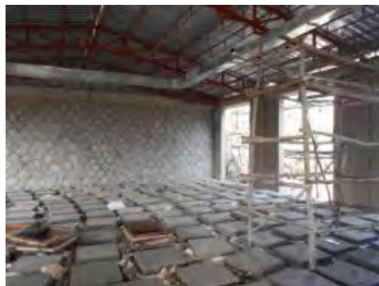
事務棟内部の様子(内装工事途中)
