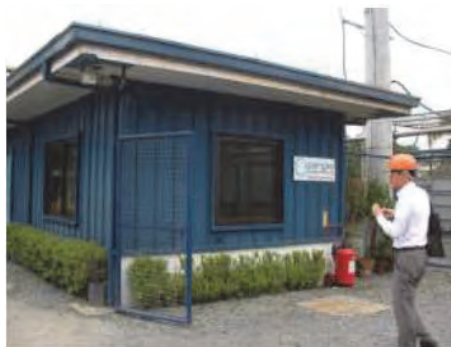
メタンガス回収施設の外観
