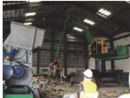
破碎工程の様子
