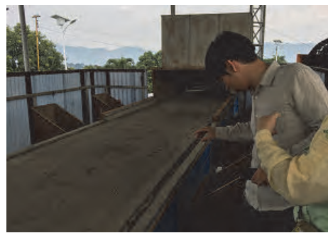
選別コンベヤの様子
