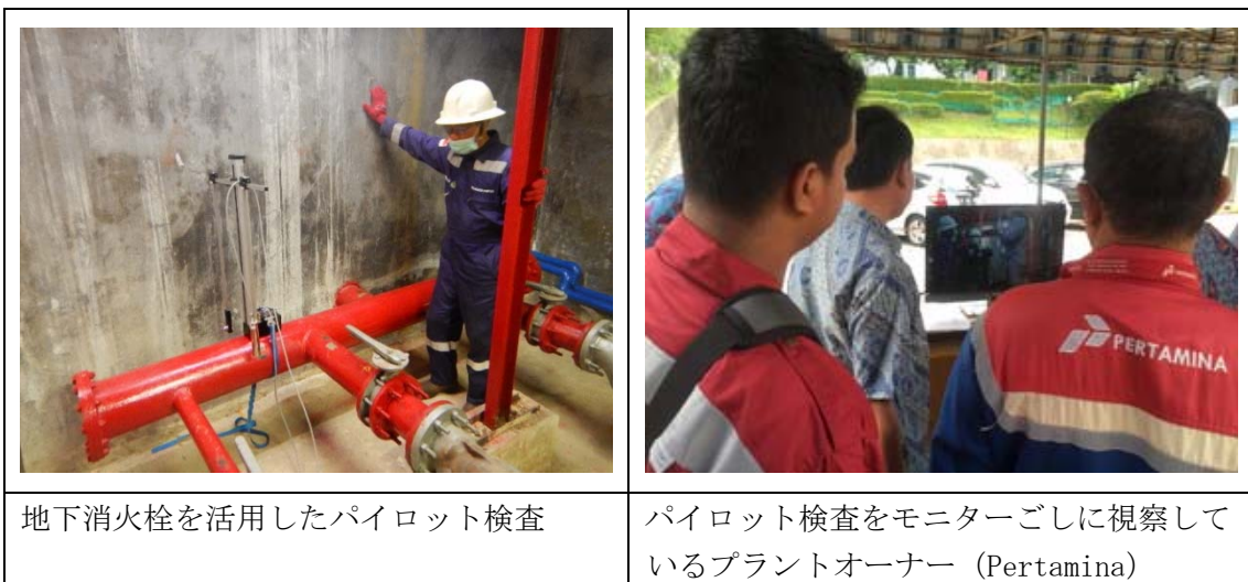
図 14 バリクパパンにおけるパイロット検査の実施風景
