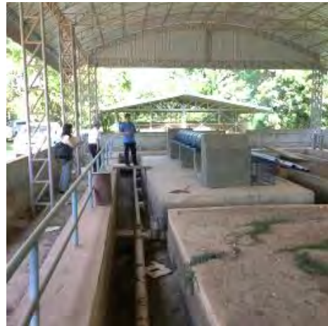
配管布設研修
