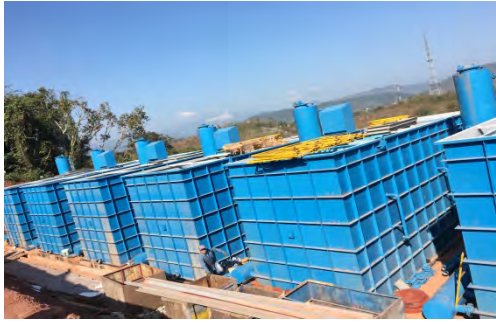
DEMCO 社浄水場建設現場
