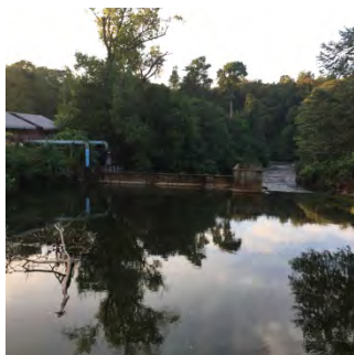
KM33 浄水場の取水口 (KM36)
