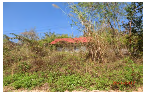
Souphanouvong 大学（配水池）
