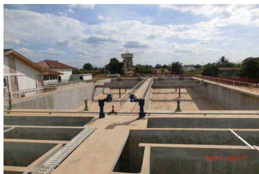
Thaduea 浄水場 (建設中)
