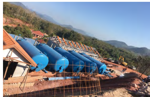
DEMCO 社浄水場建設現場
