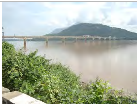
排水口付近からメコン河を望む (手前わずかに川の水の色が違う)
