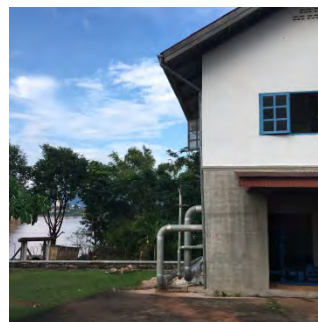
Phonthong 郡浄水場
